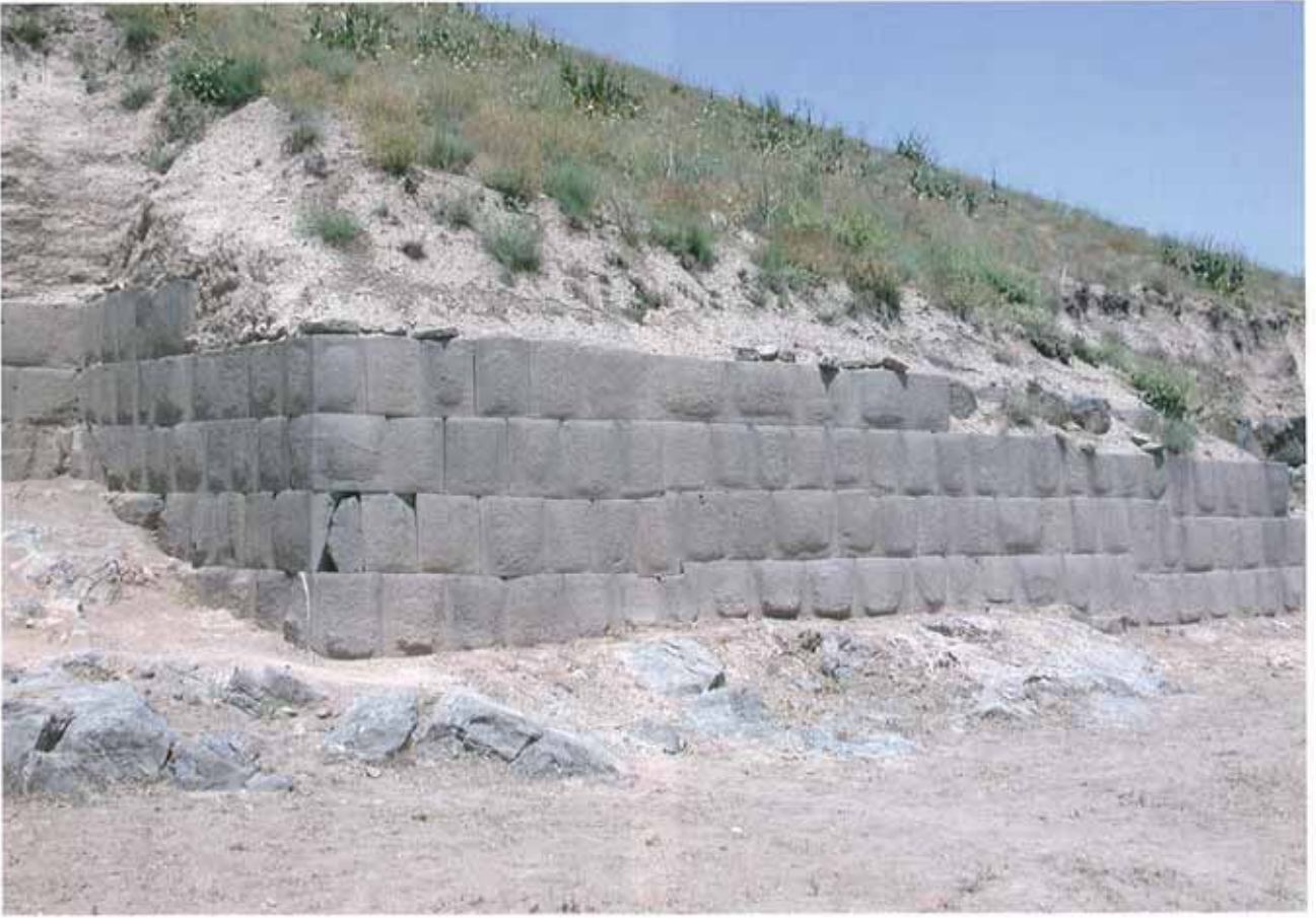
Res. 6: Ayanis gúney sur duvar temelleri.
